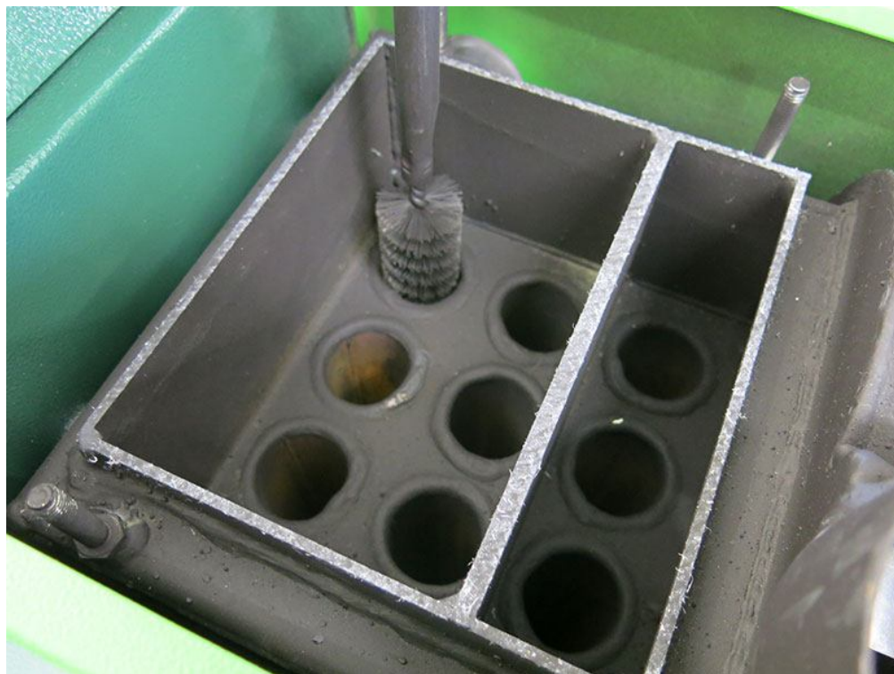
Рис. 36 - Чистка трубчатого теплообменника
